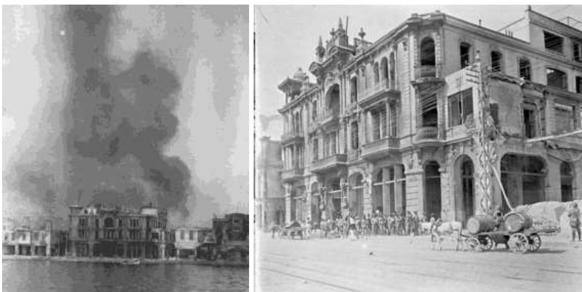
Το ξενοδοχείο Splendid κατά τη διάρκεια και μετά την καταστροφική πυρκαγιά.
